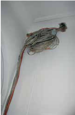
Fahrlässiger Umgang mit Elektrizität. Hygiene macht hier keinen Spaß; Waschraum der Schule
