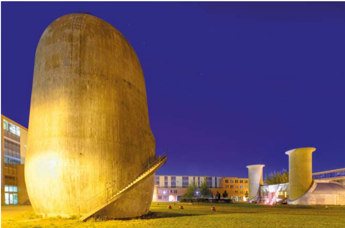
Der Aerodynamische Park mit Trudelturm und Motorenhöhenprüfstand ist eine historische Attraktion in Adlershof.
